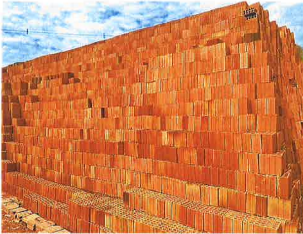
Figura 09 – Armazenamento em local aberto
